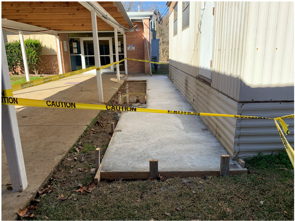
Figure 1 – Concrete Pour for ADA Ramp Install
