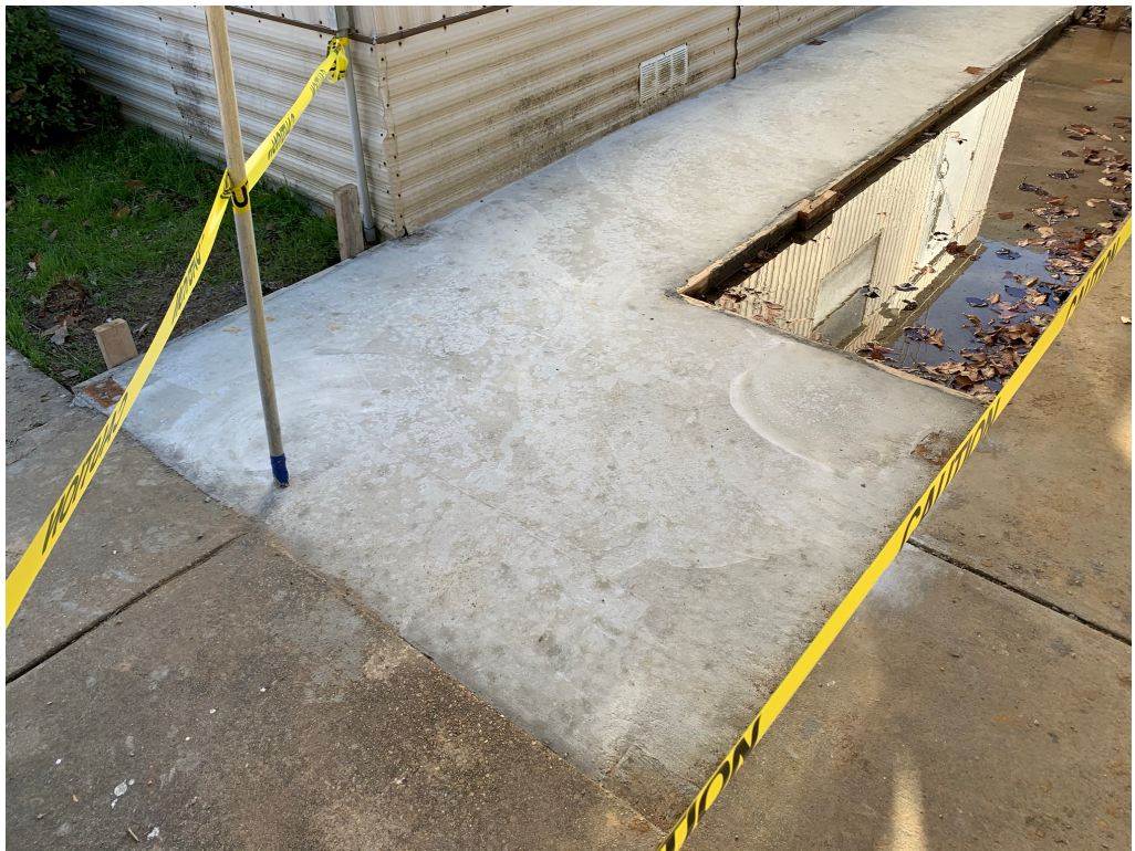
Figure 2 – Concrete Pour for ADA Ramp Install
