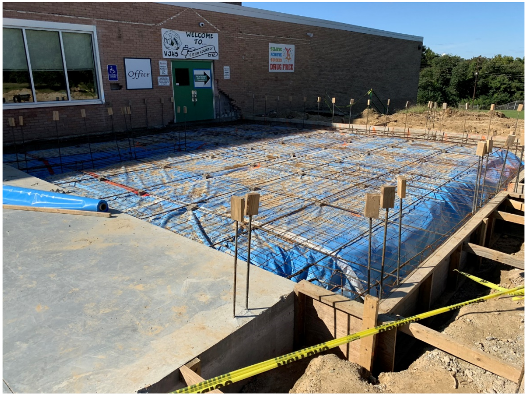
Figure 1 – Reinforcing @ Slab Pour
