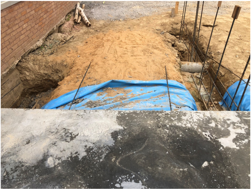
Figure 7 – First Section of Slab Pour
